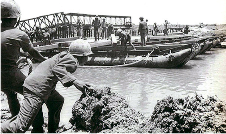
Công Binh đang lập cầu phao băng ngang sông Mỹ Chánh, Quảng Trị.
