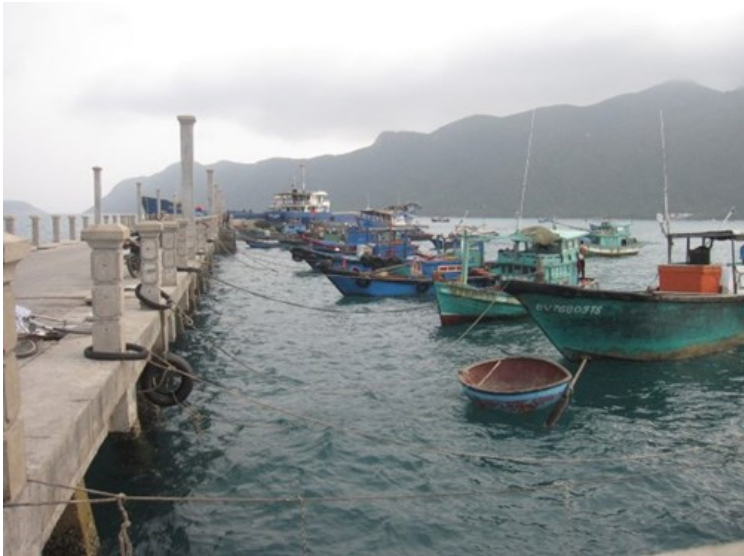
Cầu tàu Côn Đảo
